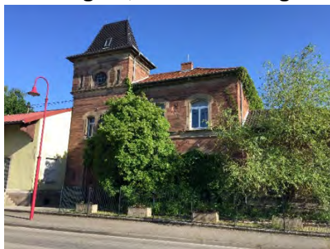
La gare désaffectée à Pfaffenhoffen
